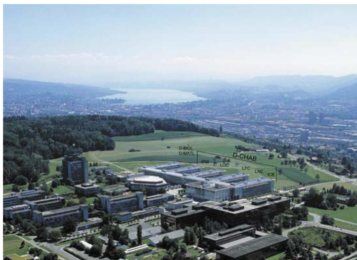
Abb. 6. Chemiegebäude (HCl) auf dem Hönggerberg (2004) mit Hörsaal-Bibliotheks-Trakt, Zentralgebäude (vor allem für die Lehre) und den fünf „Fingern“, in denen neben einem Teil der Biologie und den Materialwissenschaften die fünf Institute des Departements für Chemie und Angewandte Biowissenschaften (D-CHAB) untergebracht sind. (Quelle: Corporate Communications, ETHZ)
