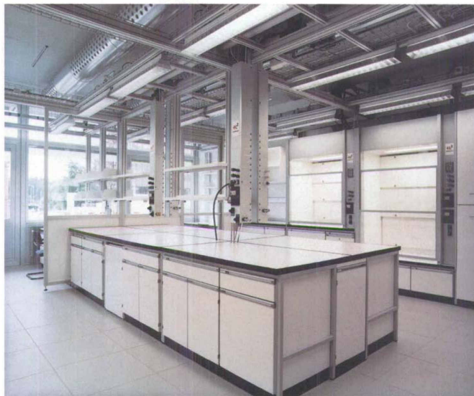
Fig. 1. Die Modularität und Mobilität des Laborsystems machen auch vor dem Mobiliar und der Medienversorgung nicht Halt.
