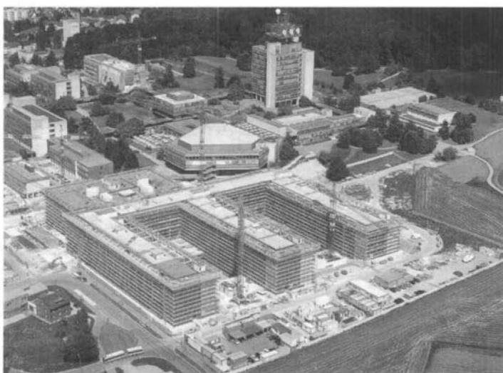
Fig. 1. Die dritte Ausbaustufe ETH Höggerberg stellt einen Quantensprung in der bedarfsgerechten Erstellung und in nachhaltigen Betrieb von Grossbauten dar.
